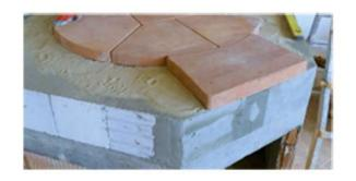
Creare il piano di appoggio di circa 100cm. Sul piano di appoggio collocare i blocchi in calcestruzzo cellulare dello spessore di almeno 10cm e livellare all'occorrenza.
